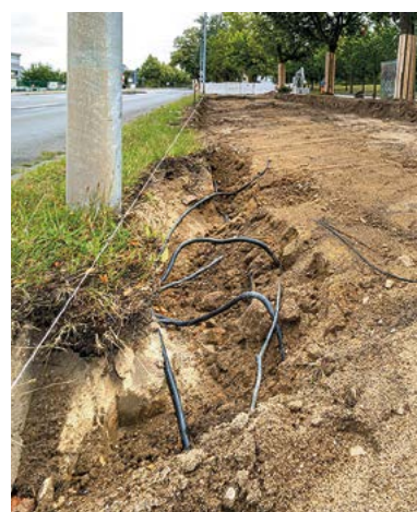
In der Cottbuser Straße werden die Stromkabel für die Straßenbeleuchtung gelegt.
