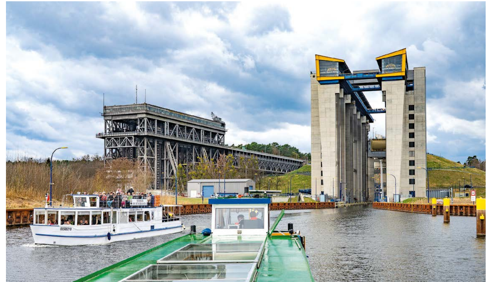
Einen imposanten Blick über Niederfinow bietet sich den Besuchern auf der Aussichtsplattform des rund 55 Meter hohen neuen Schiffshebwerks. Daneben das historische Schiffshebewerk.
