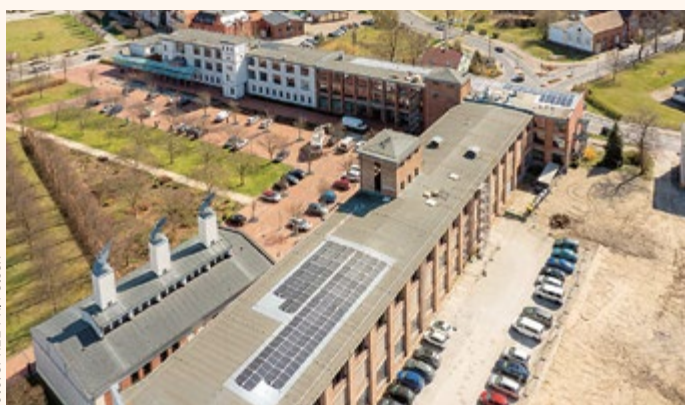
Aus der Luft werden die umfangreichen Dacharbeiten auf den Gebäuden in der Gasstraße deutlich. Die Aufnahmen entstanden Anfang April, als ein erster Teil der Anlagen installiert worden war.
