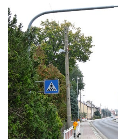
Die Freileitung im Gubener Norden wurde schon demontiert
