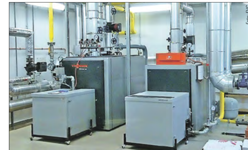
Dank moderner Technik werden Teile Gubens mit Nahwärme versorgt.
